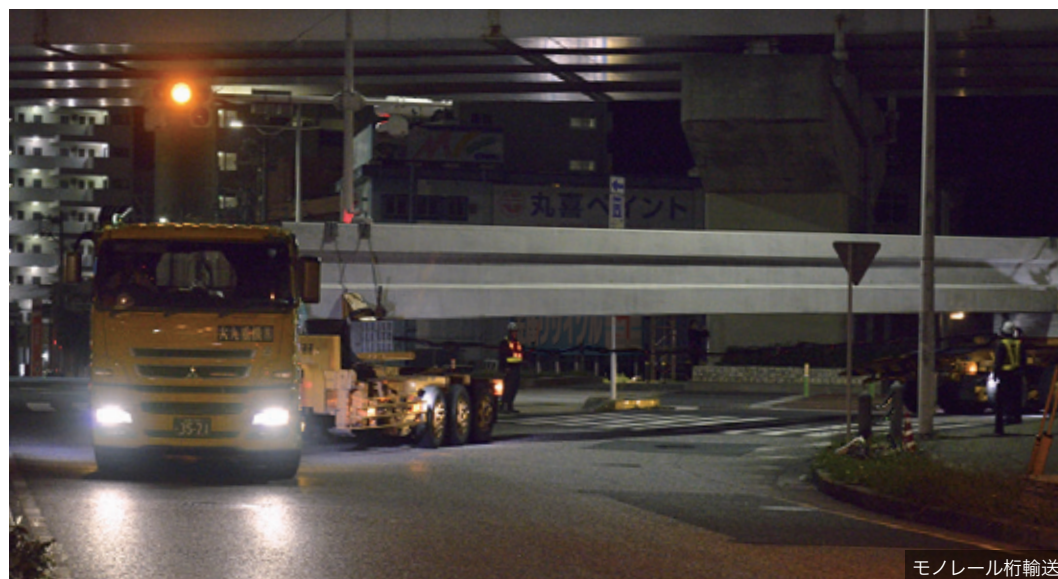
モノレール桁輸送
