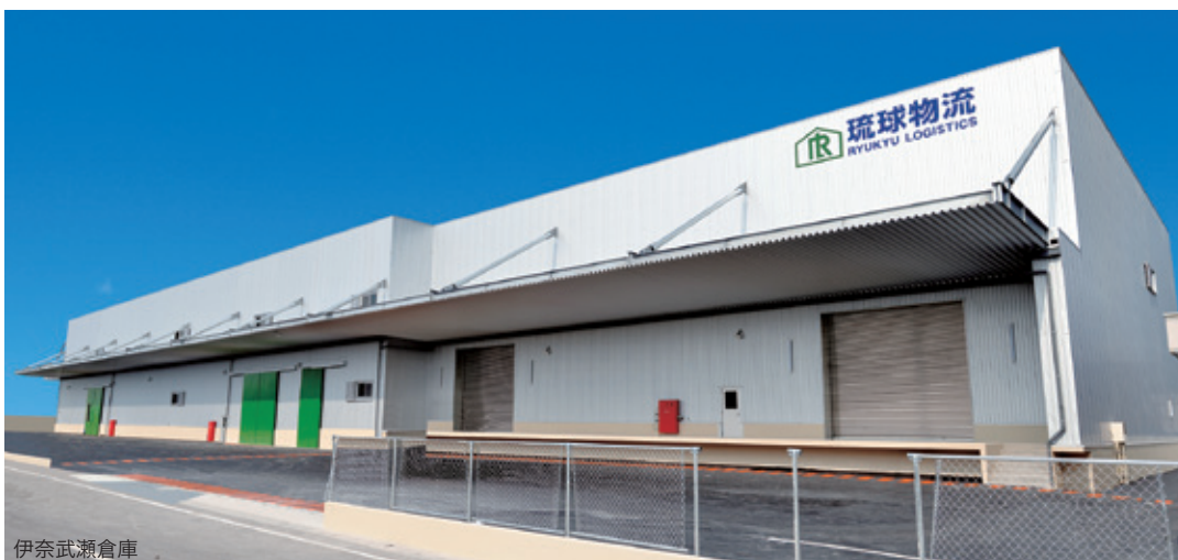
伊奈武瀬倉庫
