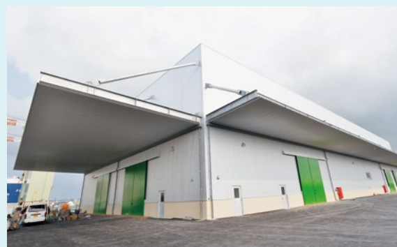
大型の庇を設置し、雨天時においても安全作業が可能
