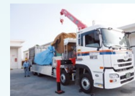
PCB産業廃棄物 積み付け作業風景
