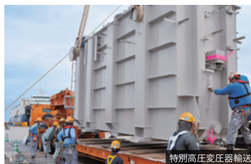
特別高圧変圧器輸送
